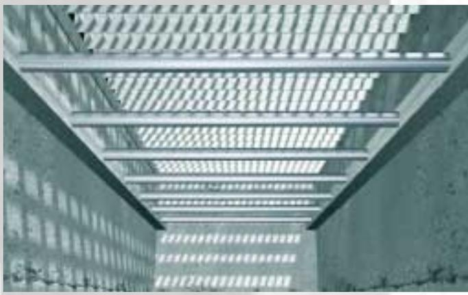
Lichtschachtabdeckung aus Glasstahlbeton
